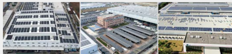
廣汽部件園區光伏項目建設
