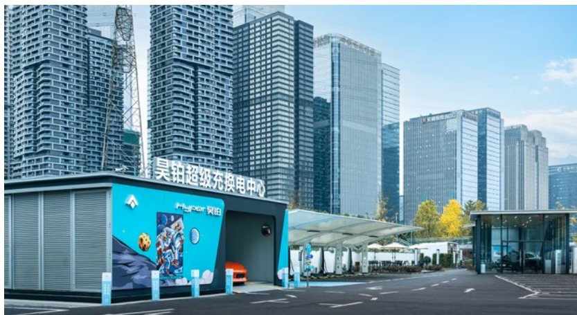
昊铂超级充换电中心
